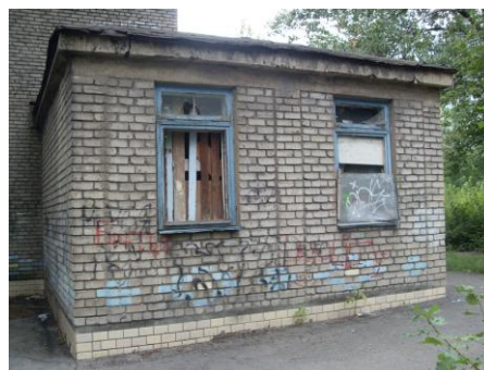
Фото 15-16. Разрушение деревянных конструкций окон и отсутствие остекления первого этажа и в пристройках
