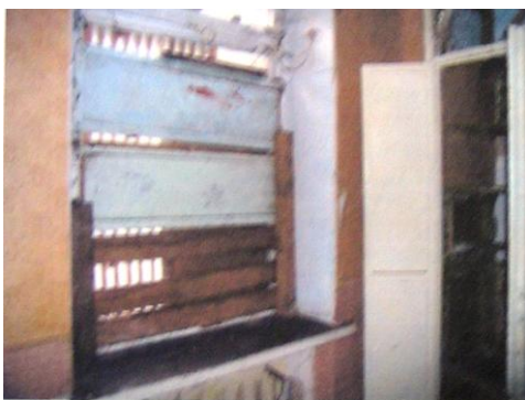
Фото 15-16. Разрушение деревянных конструкций окон и отсутствие остекления первого этажа и в пристройках
