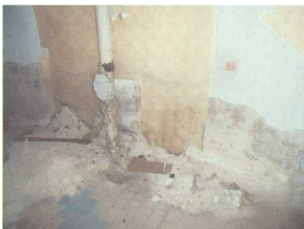
Фото 19-20 Дефекты отделки в санузлах, отсутствие санитарных приборов, отсутствие батарей отопления по всему зданию
